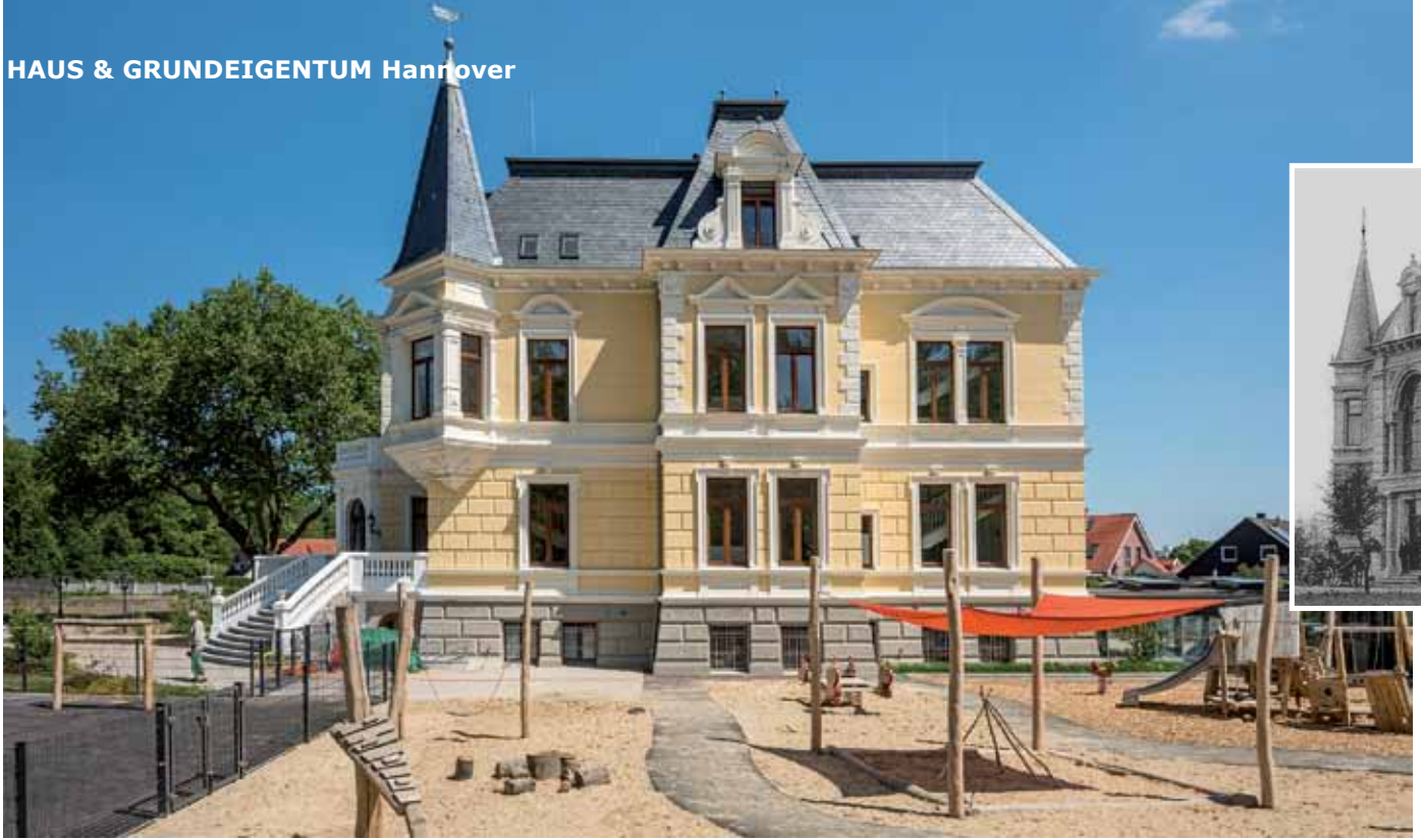
Die Villa Nordstern heute nach der umfangreichen Sanierung.
